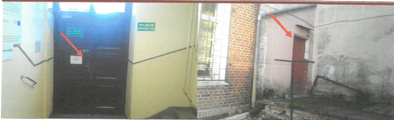
Widok na wejścia główne W1 oraz wyjście W2 z kotłowni
