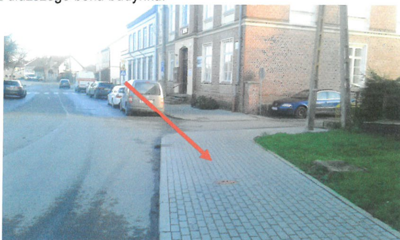
Widok na drogę pożarową oraz hydrant podziemny .
