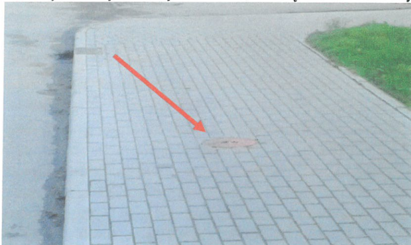
Widok na drogę pożarową oraz hydrant podziemny .
