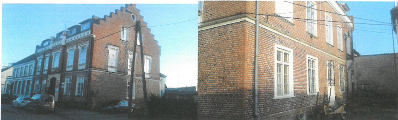
Widok na budynek Urzędu Miejskiego w Sępólnie
