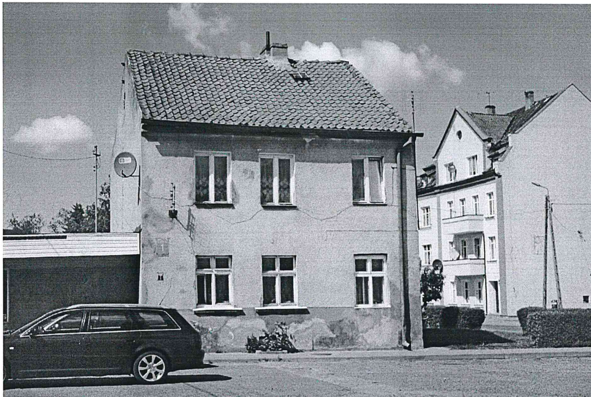
Fot. 1 Elewacja frontowa
