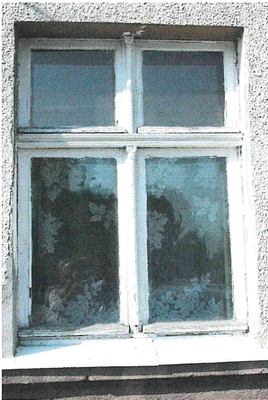
Oryginalne okno wyposażone jest w półwałki na listwach przymykowych, cynowe kapitele i profilowane ślemię.
