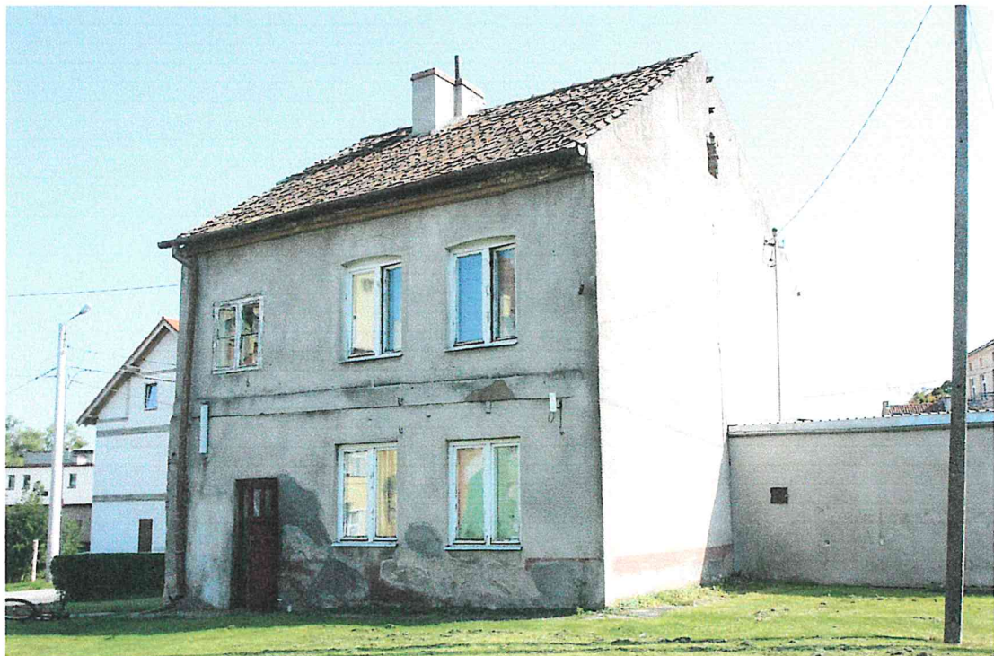
Widok ogólny elewacji podwórzowej.
