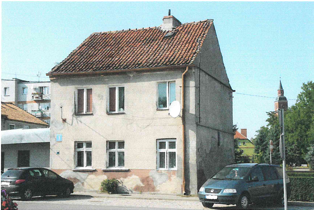
Widok ogólny elewacji frontowej.
