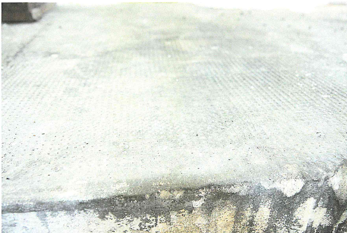
Betonowa posadzka i stopnie były fakturowane.
