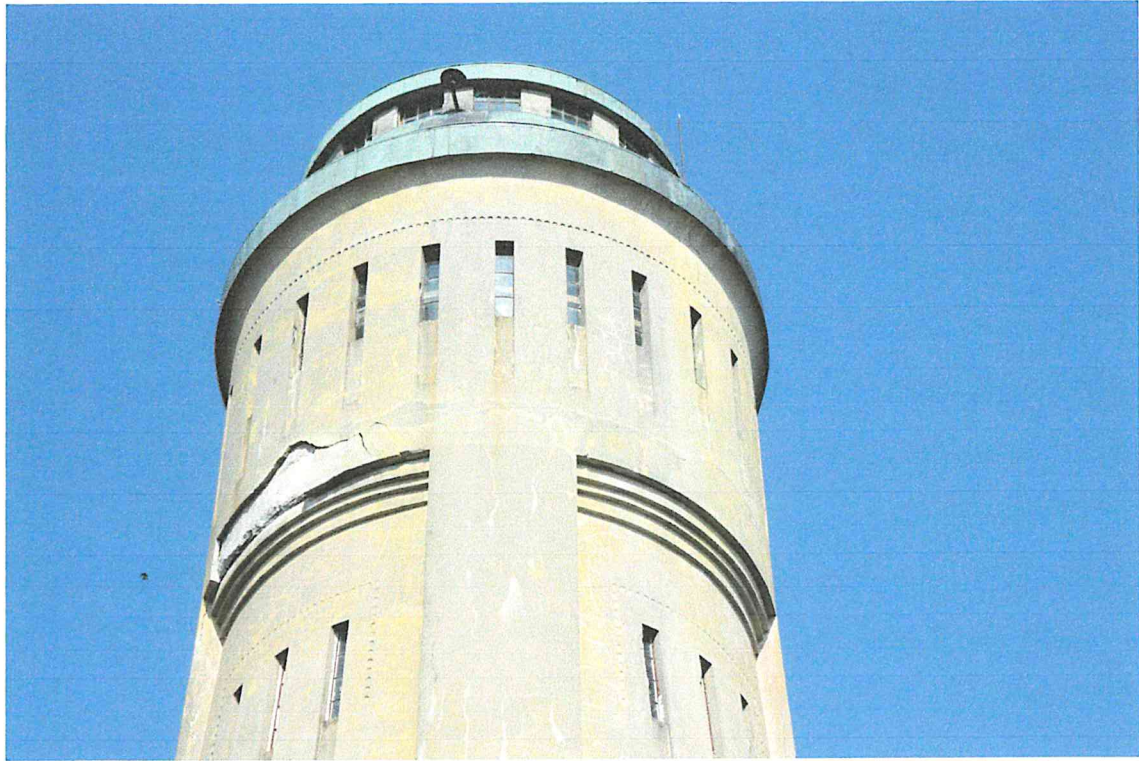
Z górnej strefy wieży oberwał się duży fragment tynku.
