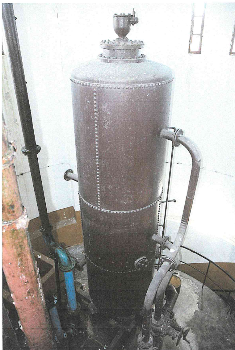
Wnętrze wieży wraz z zabytkowym wyposażeniem.
