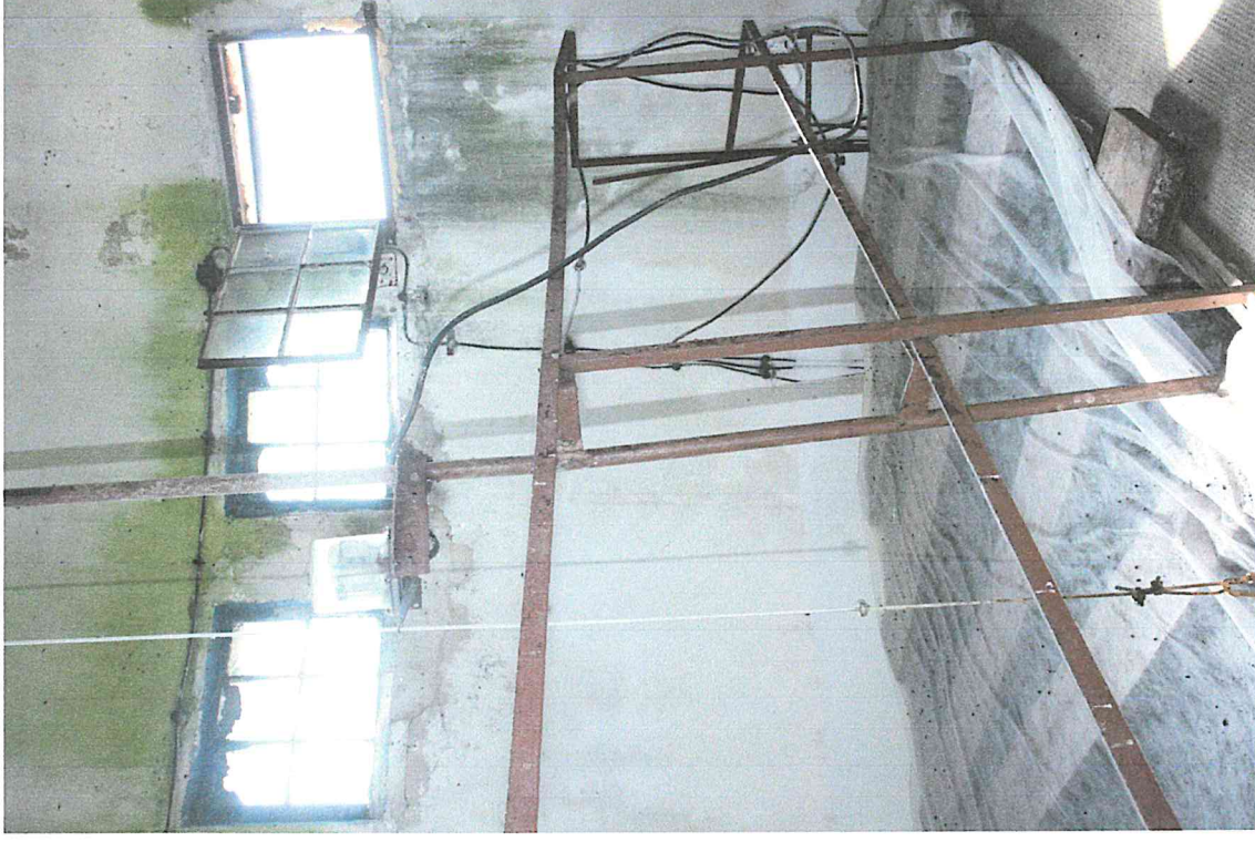
Najwyższa kondygnacja wieży. Instalacja elektryczna jest niesprawna i nieuporządkowana.
