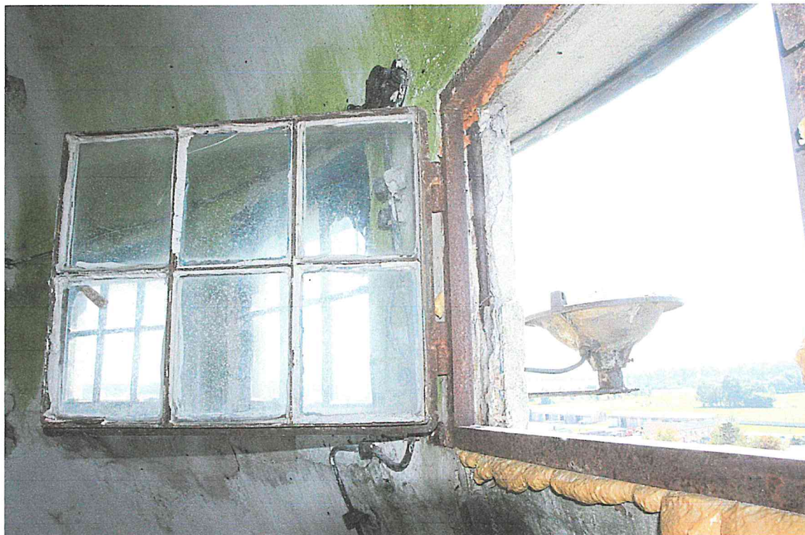
Na zewnątrz wiszą nieczynne, oryginalne lampy.
