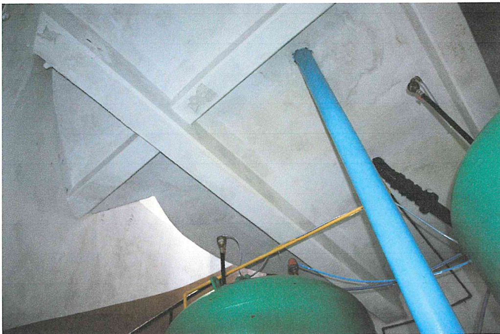
Stalowe belki stropu ponad parterem.
