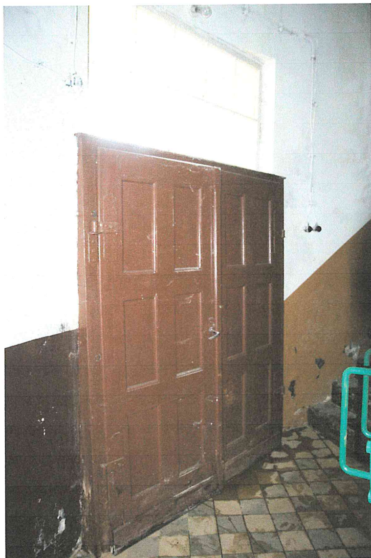
Oryginalne drzwi wewnętrzne.
