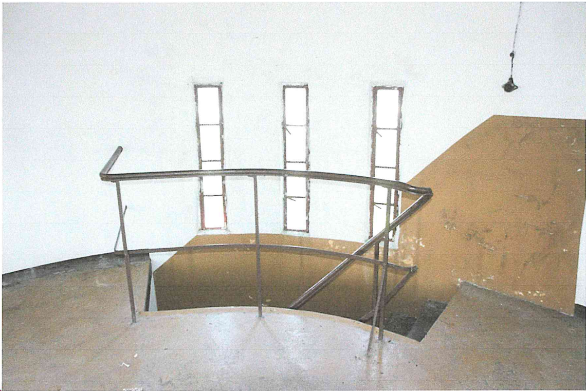
Metalowa balustrada na, na której wykonano odkrywkę.
