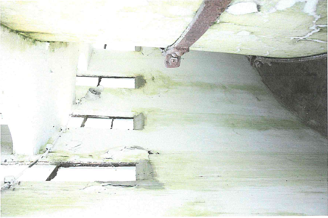
Obejście wokół zbiornika na wodę. Obejma spinająca zbiornik jest pokryta produktami korozji.
