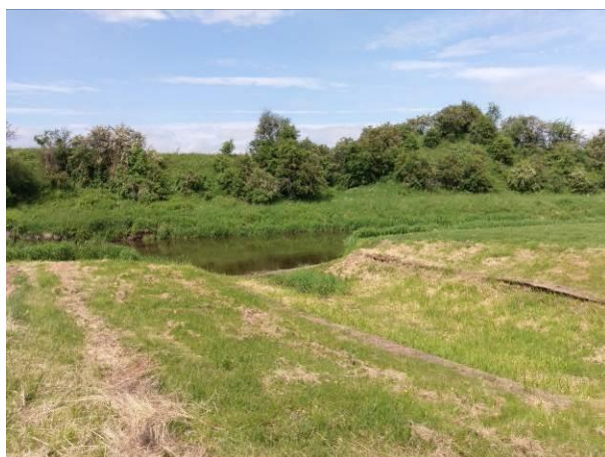
Fot. 12. Widok na istniejącą część rekreacyjną (zachodnia część obszaru opracowania), maj 2019 r.
