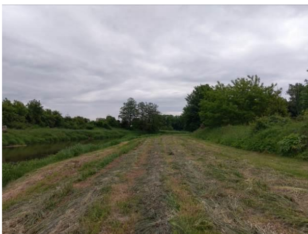
Fot. 5. Widok na działkę 234 w kierunku północno-wschodnim (środkowa część obszaru opracowania), maj 2019 r.
