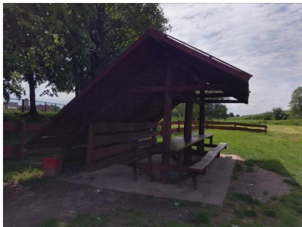
Fot. 10. Widok na istniejącą część rekreacyjną (zachodnia część obszaru opracowania), maj 2019 r.
